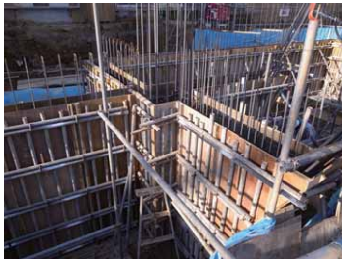
配筋、型枠工事
