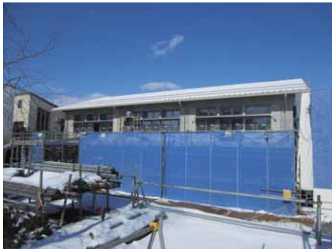
校舎（二期）工事の外装も徐々に見えてきました。
