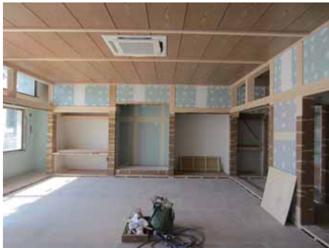
家庭科室 和室の内装
