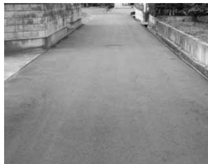
補助を受けて整備した私道
