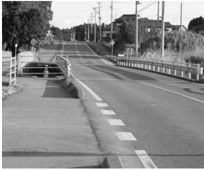
県道棚倉～矢吹線三文橋
