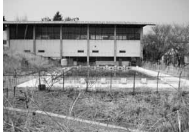
改築工事を待つ矢吹中学校
