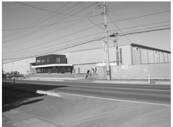
(矢吹町に進出した川合運輸) 旧第一苗畑に建設中
