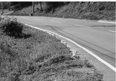
うぐいす橋付近の被災箇所
