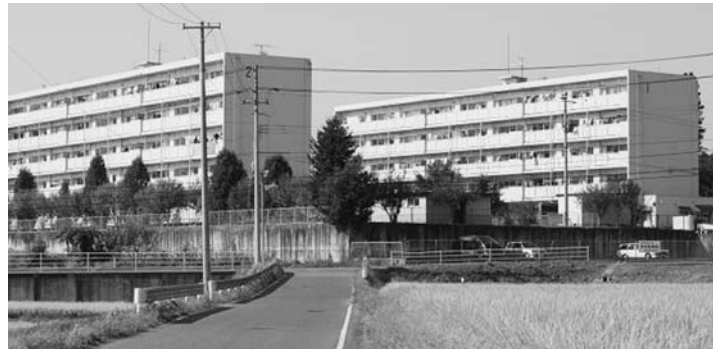
廃止される雇用促進住宅
