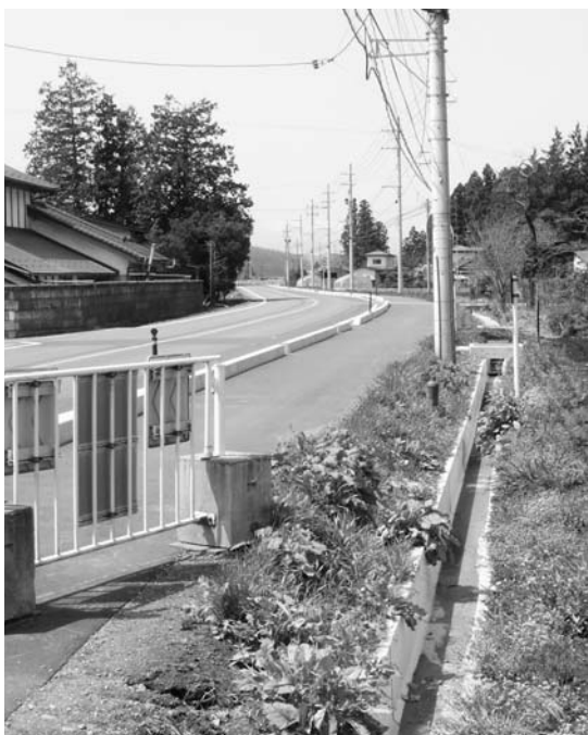
県道の歩道整備
