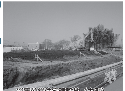
災害公営住宅建設地(中町)
