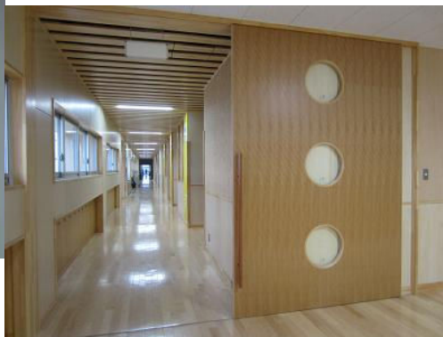
廊下に設置されている扉
