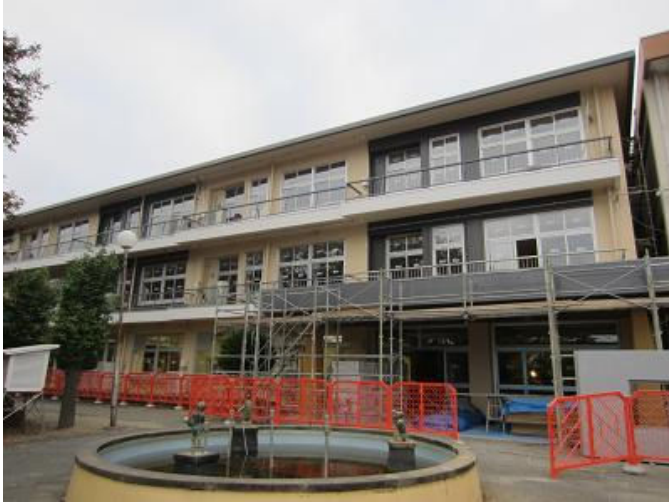
西校舎（昇降口側から撮影）
