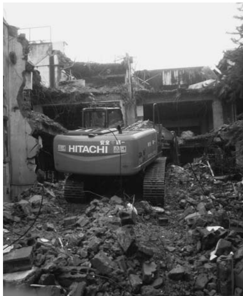
損壊家屋の解体工事
