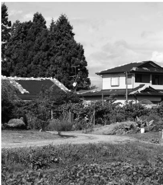
一部損壊住宅の屋根瓦の状況
