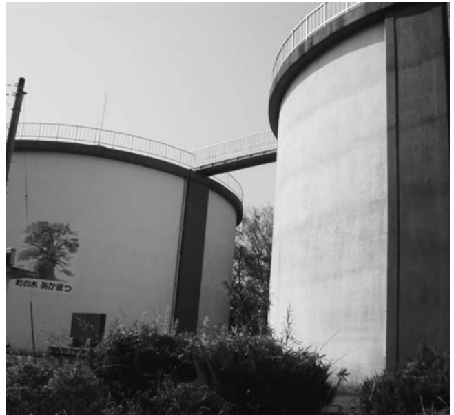
五本松配水池
