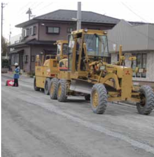
道路復旧工事
