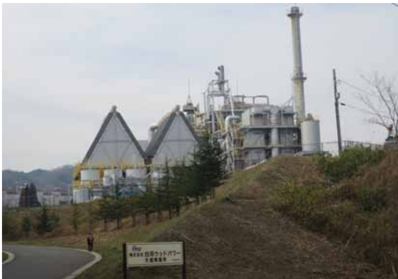
大信のバイオマス発電所
