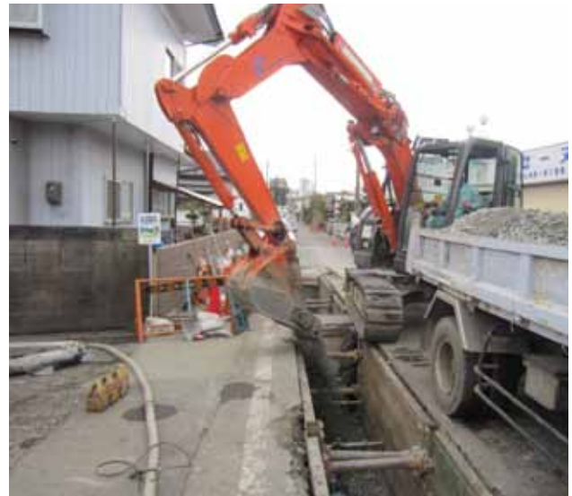
災害復旧工事現場
