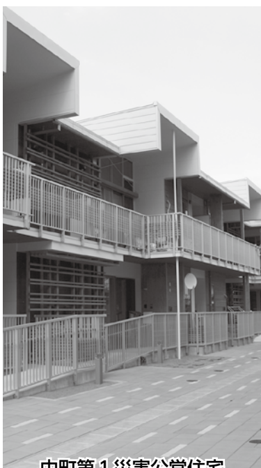
中町第1災害公営住宅
