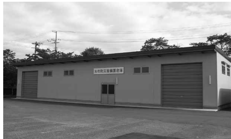
備蓄庫（役場駐車場）
