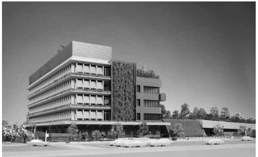
三鷹中央防災公園・元気創造プラザ
