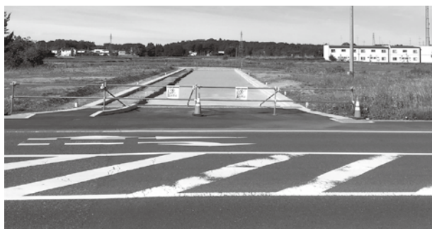
工事中の新町西線
