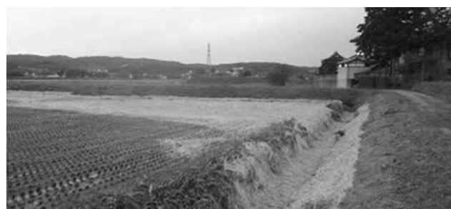
台風による被害
