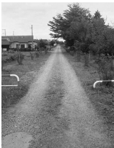
未舗装の幹線水路敷
