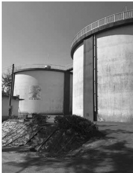
水道施設（五本松配水池）
