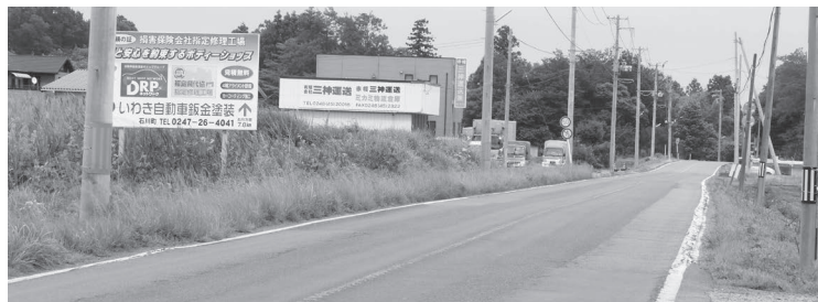
県道石川矢吹線の歩道未整備区間
