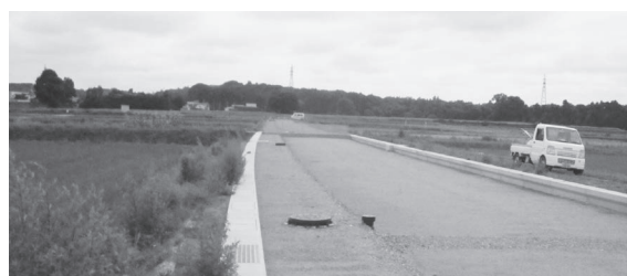
整備中の町道新町西線
