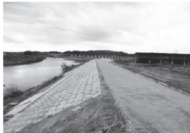
（復旧工事が完了した中沖地区の堤防）
