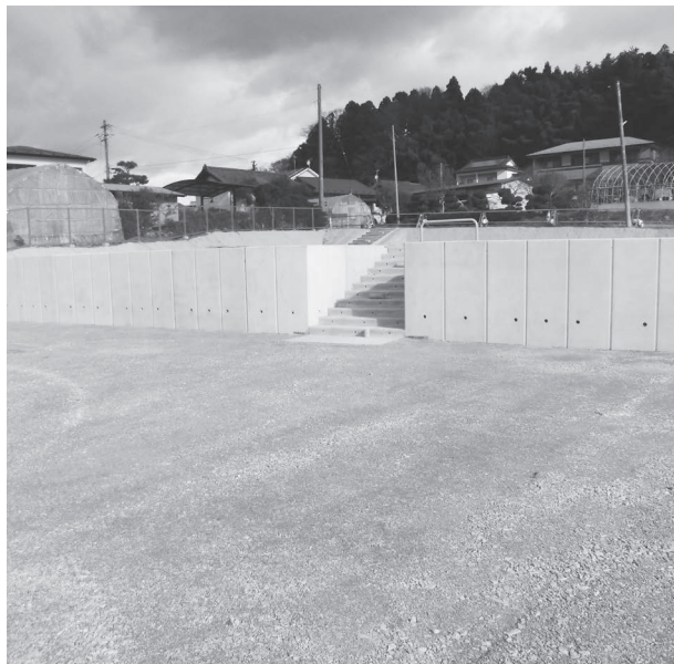
L字擁壁の部分
