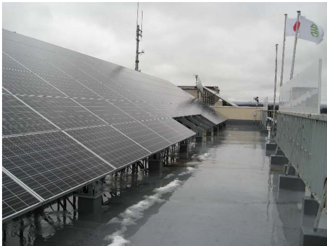
屋上 太陽光パネルの設置状況。 手前の掲揚塔が傾いている。
