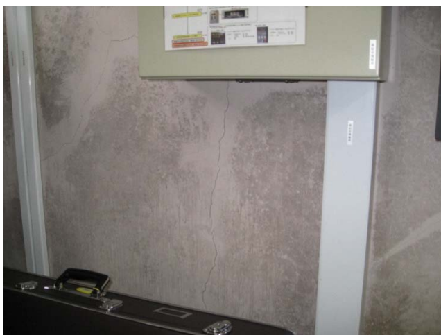
2階防災行政無線室 壁面に複数のクラックが見られる。
