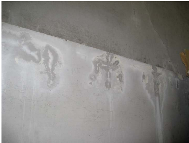
階段室（中央） 壁面にクラック・白華が見られる。
