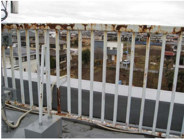
屋上手摺 手摺に錆が見られる。
