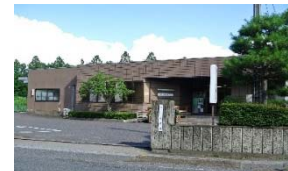
③上水道管理棟
