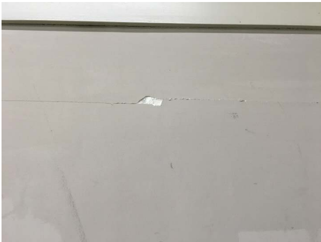
3階第4会議室 壁面にクラック・剥がれが見られる。
