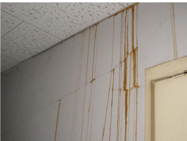
階段室（西） 壁面にクラック・雨漏り跡が見られる。
