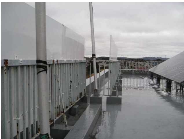
屋上 掲揚塔近景。 根元から傾斜している状況が 見られる。
