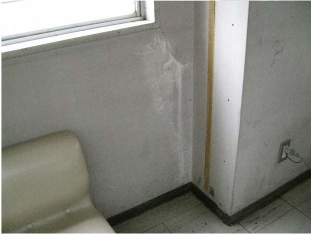
1階執務室 窓下のクラック・白華現象が見られる。
