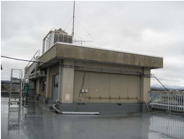
屋上 ボイラー室全景。 壁面にクラックが見られる。
