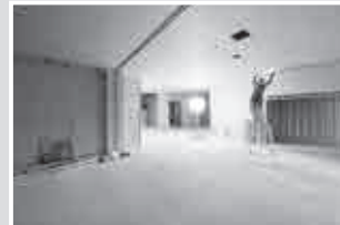
1階多目的室内装工事
