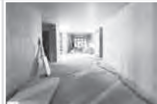
1階ギャラリー内装工事
