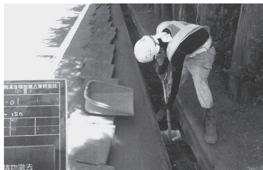
側溝堆積物撤去の様子
