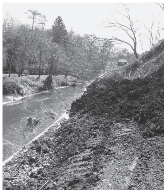
南町町道土砂崩れ現場
