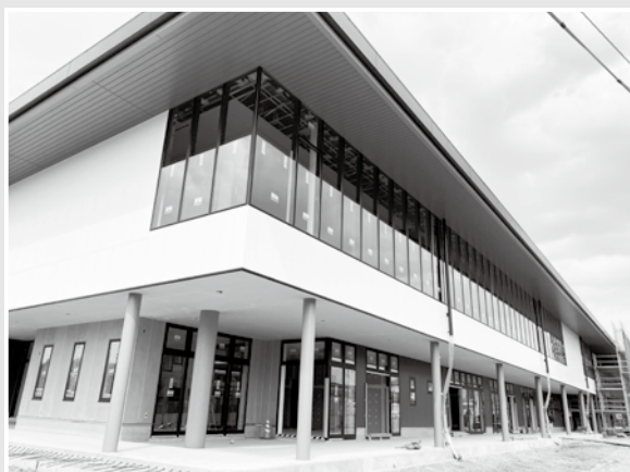
▲外部足場の一部が解体完了しました
