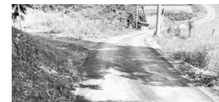
工事場所：明新原地区
