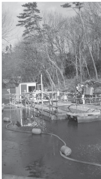
しゅんせつ 浚渫工事
