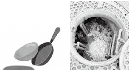
詰まった状態の 下水道施設
