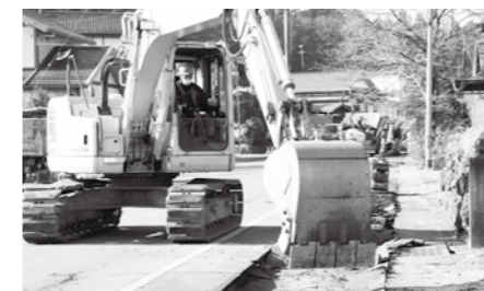
応急復旧工事
