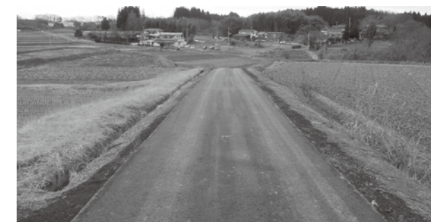
工事場所：明新原地区
