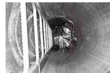
正常な下水道施設
