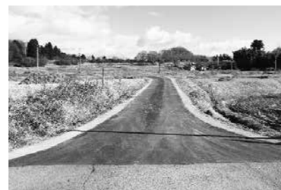
(位置:中丸地内) 延長 L=100m 幅員 W=2.2m
