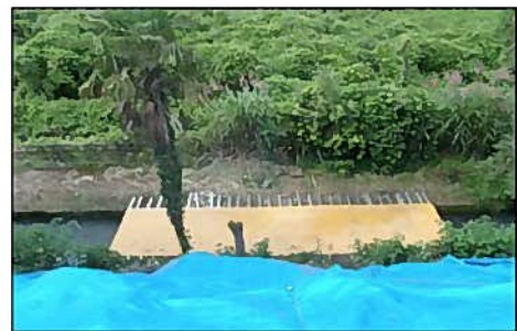
水路への仮蓋の設置
