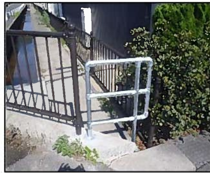
侵入防止柵を設置 (新潟県新潟市)
