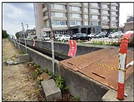
応急ロープの設置
