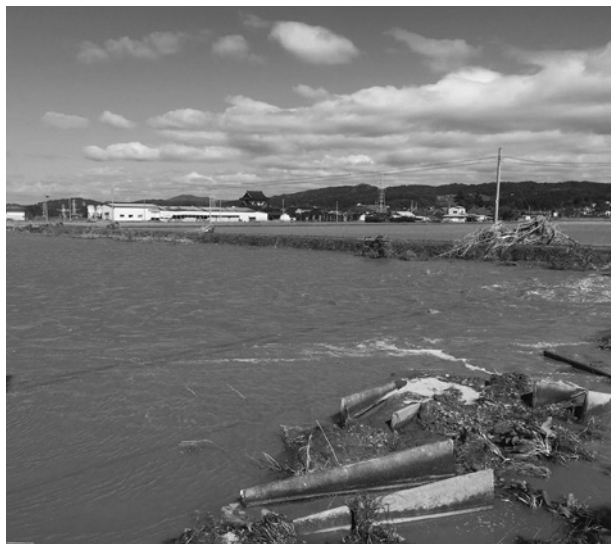
水没した三城目地区の農地（令和元年10月20日撮影）
