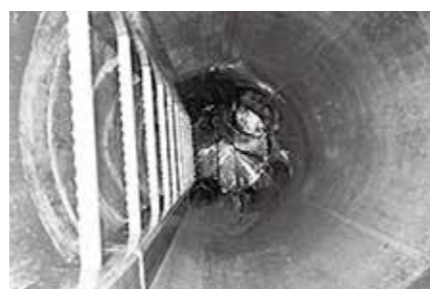
正常な下水道施設
