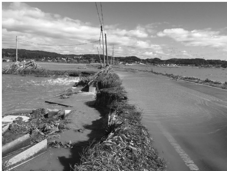
令和元年台風19号で冠水した農地
