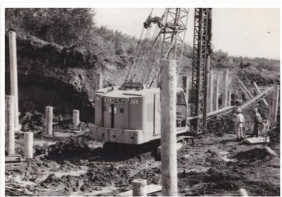
当時の打込み機です。ハンマー打撃工法により施工していました。
