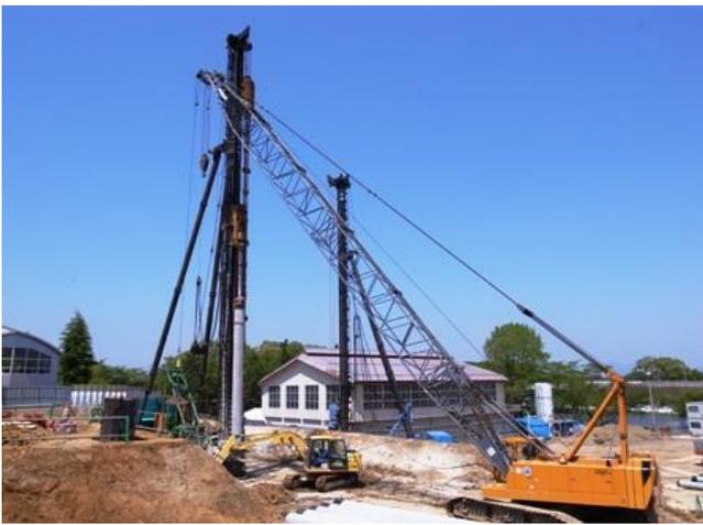
クレーンは総重量65t、排気量6,800cc、出力180ps、最大65tまでの吊上げが可能です。
