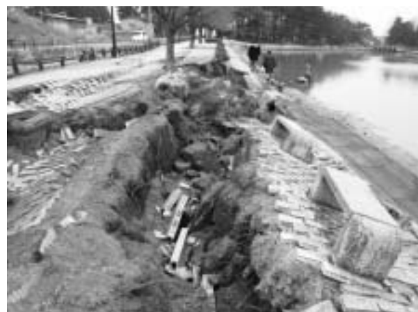
■大池(ため池) 復旧前
