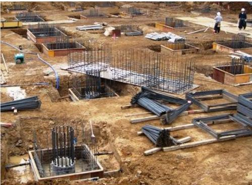
フーチングの配筋、型枠の設置状況です。
