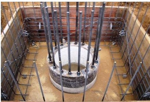
配筋完了後、型枠がセットされます。
