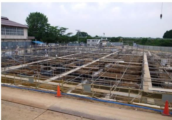
配筋を行うための鉄筋足場が設置されて
