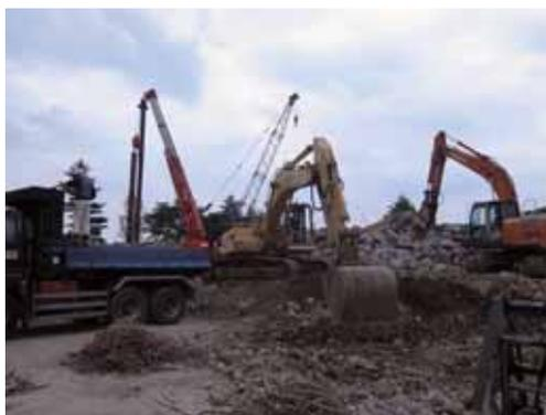
鉄筋コンクリートの柱や梁は細かく破碎し、コンクリートと鉄筋に分別されリサイクル施設で処理されます。
