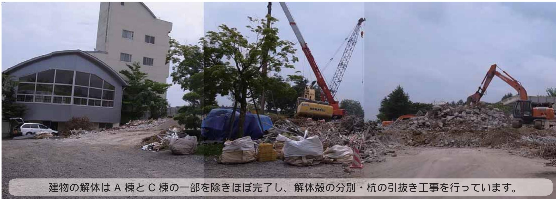
建物の解体は A 棟と C 棟の一部を除きほぼ完了し、解体殻の分別・杭の引抜き工事を行っています。
