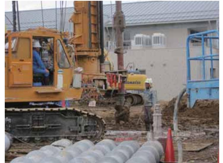
地盤の状況を確認しながら、確実に支持層まで掘削します。
