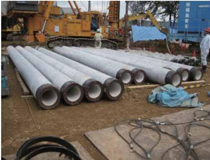
杭径は 45 ~ 80 cm、約 70 セットの杭を設置します。
