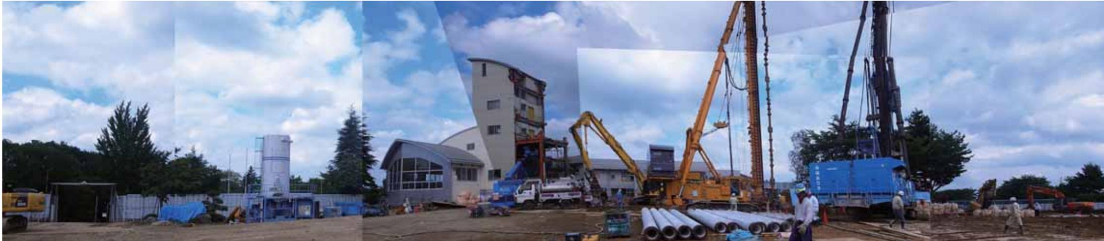
旧校舎の解体工事、造成工事が完了し校舎 期工事、プール・武道場建設の基礎工事が始まりました。今回の工事も校舎 期工事、体育館工事と同様に、地盤が軟弱なため地下約 30m の強固な支持層まで杭を埋め込み、建物を支えます。今回の工法は、ハンマー等で杭を打ち込む工法ではなく、あらかじめ地盤に穴を開けコンクリート製の杭を埋め込み、周囲をセメント系の固化材で固める「埋め込み工法」を採用しています。無振動、無騒音の工法であるため、学校運営への影響を最小限に抑えることが可能となります。
