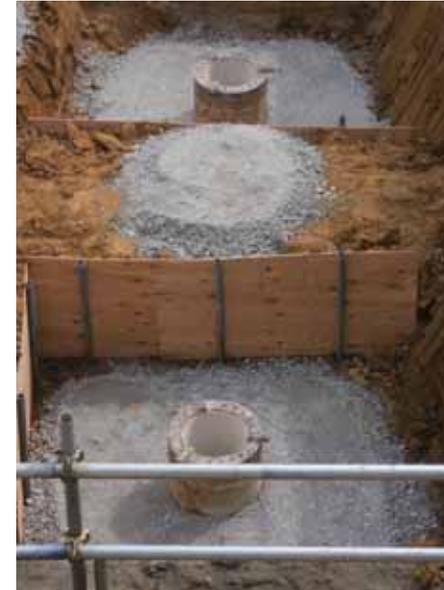
杭の上部に縦 1.5m × 横 1.5m 高さ 1.6m の基礎が設置されます。
