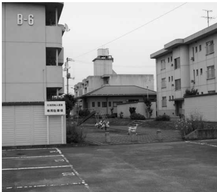
入居困難な町営住宅
