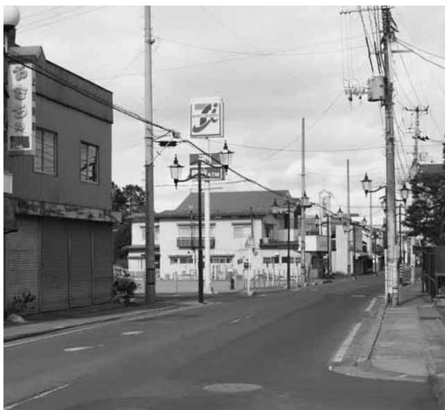
早期復興が望まれる商店街（中町地区）
