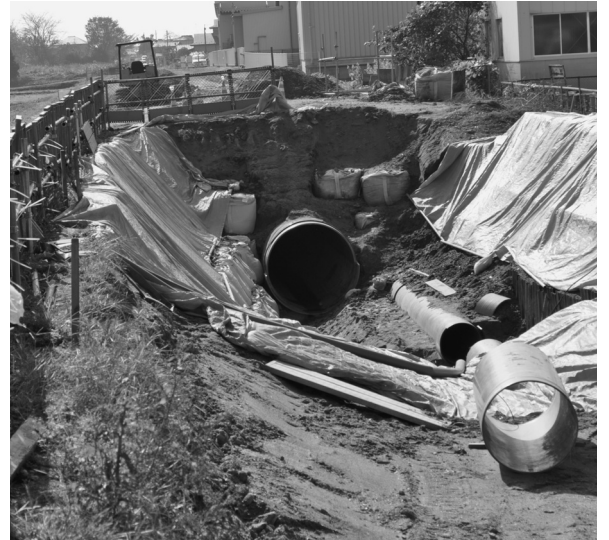
羽鳥用水路復旧工事
