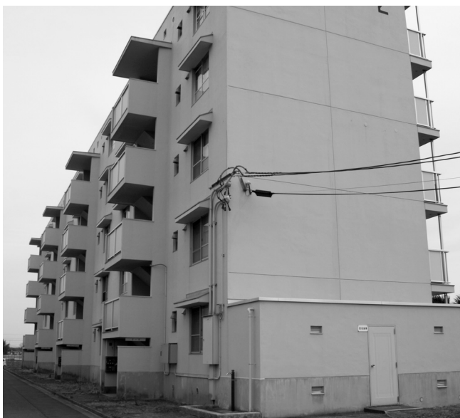
傾いた北町雇用促進住宅
