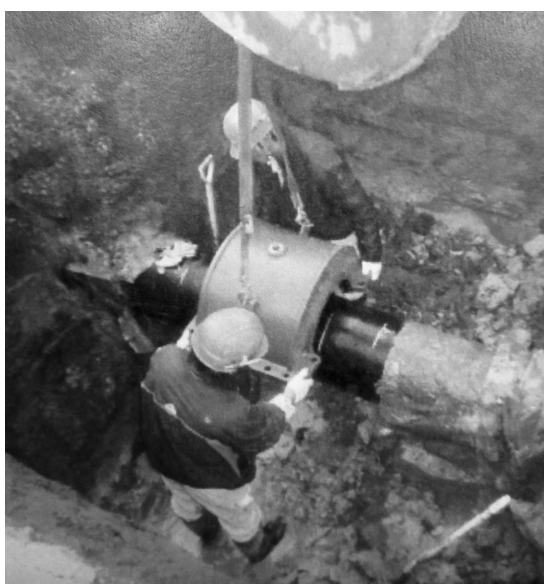
農業集落排水工事
